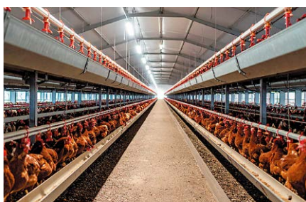
スレート屋根鶏舎
