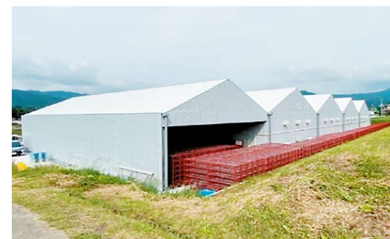
屋根型5連棟キノコハウス(新築)
